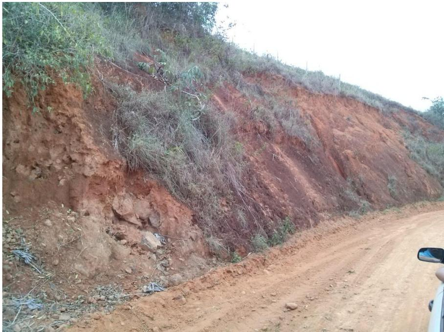
Fig. 39 - Perfil de Corte - Material residual.
