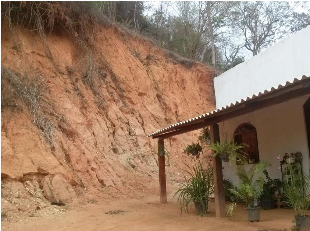
Fig. 17 - Impacto gerado através de cortes executados na encosta para construção habitacional.
